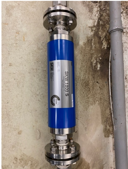
Beispiel der SKW-Anlage (Installation in Mönchengladbach im unmittelbaren Anschluss an den Wasser-Hauptanschluss des Stadions, welcher u. a. die Beregnungsanlagen erschließt)
