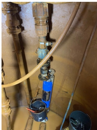
Beispiel der SKW-Anlage (Installation in Mönchengladbach im unmittelbaren Anschluss an den Wasser-Hauptanschluss der Trainingsplätze, welcher u. a. die Beregnungsanlagen erschließt)
