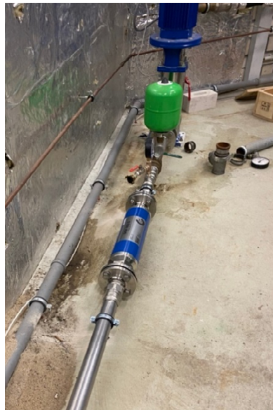
Beispiel der SKW-Anlage (Installation in Mönchengladbach im unmittelbaren Anschluss an den Wasser-Hauptanschluss des Stadions, welcher u. a. die Beregnungsanlagen erschließt)
