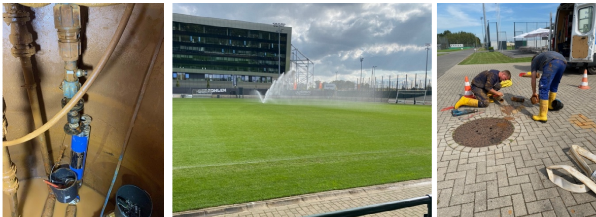
Beispiel der SKW-Anlage (Installation in Mönchengladbach im unmittelbaren Anschluss an den Wasser-Hauptanschluss der Trainingsplätze, welcher u. a. die Beregnungsanlagen erschließt)
