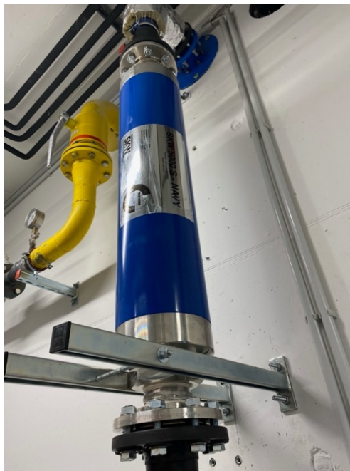
Beispiel einer SKW-Einheit (Borussia Mönchengladbach: Installation zur Versorgung des Hotel- und Verwaltungskomplexes)
